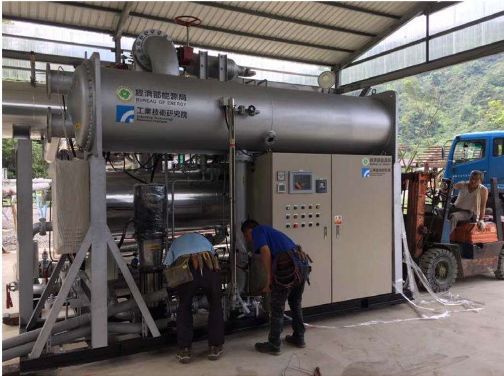
圖 183、清水地熱 200kW 發電機組定位
